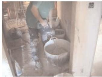
Figura 99 - Mezcladora eléctrica.
