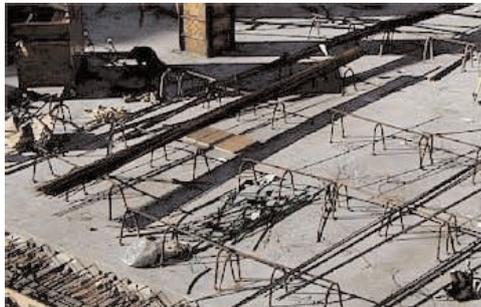
Figura 67 - Plataformas para colocar las barras.
