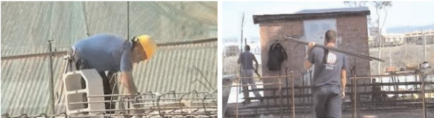
Figura 63 - Ferrallista: manejo de cargas.
