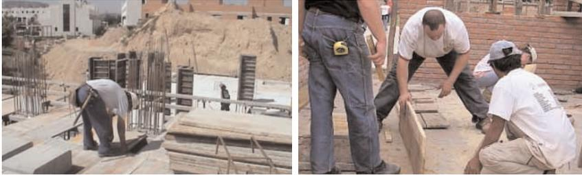
Figura 46 - Encofrador: trabajo a ras de suelo.
