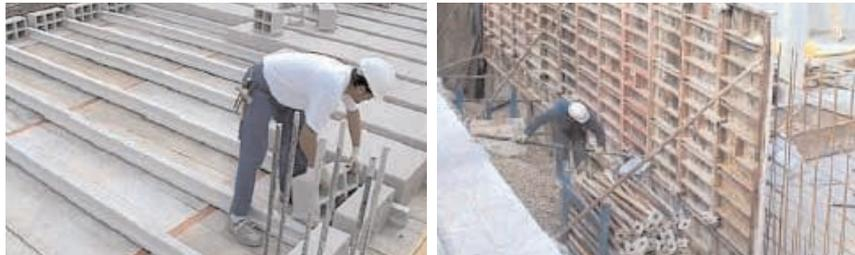
Figura 50 - Encofrador: manejo de cargas.
