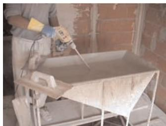
Figura 114 - Mezcladora eléctrica.
