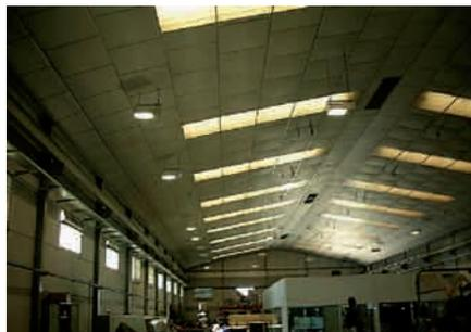
La instalación de láminas rellenas con material aislante por debajo del techo permite controlar la temperatura en el taller, inhibiendo que el calor o el frío afecte a los trabajadores y a la producción.
