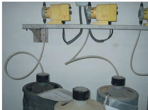
*Adición automática de reactivos mediante bombeo.*
