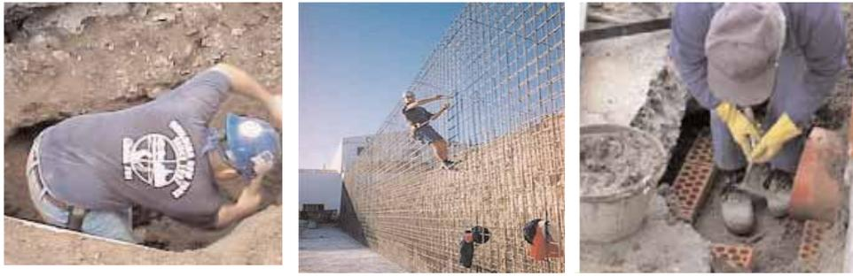
Figura 2: Ejemplos de tareas en el sector de la construcción con accesos incorrectos, superficies inestables y alturas inadecuadas
