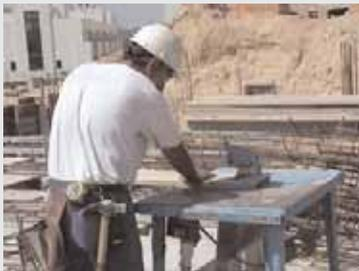
La operación fundamental que se realiza con esta máquina es el corte y aserrado de piezas de madera empleadas en las obras de construcción, sobre todo para la formación de encofrados en la fase de estructura.
