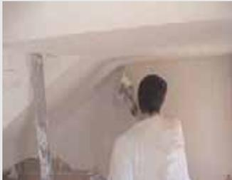
La llana es una herramienta utilizada principalmente por yesistas, escayolistas y albañiles para enlucir paredes y techos e incluso, en determinadas ocasiones, para alisar capas de cemento, cola u otro material a nivel del suelo.
